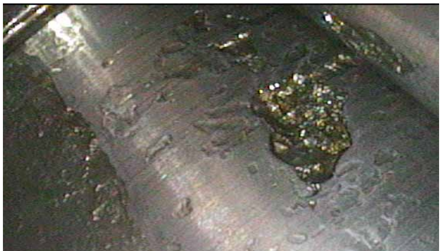
Er skaden pludseligt opstået eller på grund af slid? Det er afgørende for, om forsikringen dækker skaden. Skaden på dette planetleje blev heldigvis fundet med endoskop inden udløb af garantiperiode.
